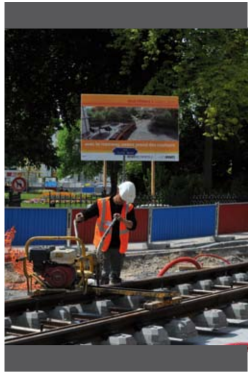
Pose de voies ferrées traditionnelles rue du Colonel Driant.
