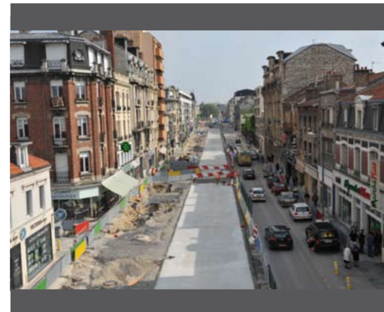
Avec près de 700 personnes qui interviennent sur le terrain, aujourd'hui plus encore, la sécurité sur les chantiers est une préoccupation au quotidien. Elle concerne aussi bien
