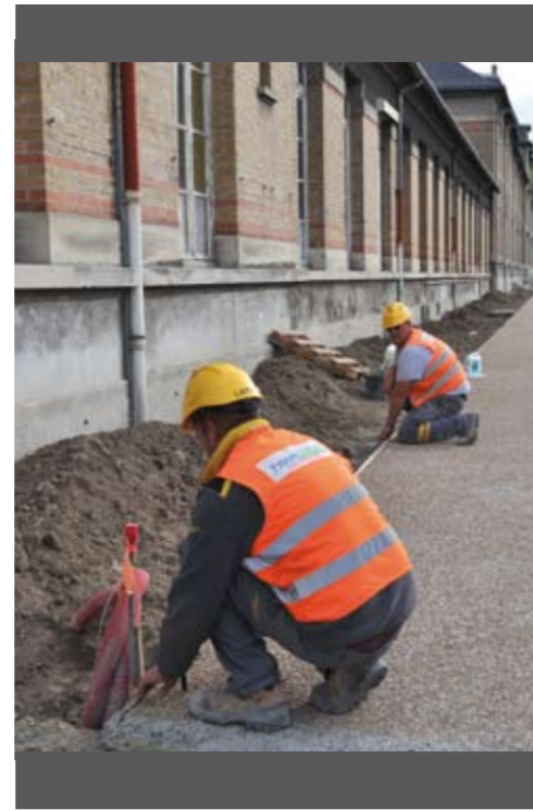
Préparation des trottoirs en béton désactivé boulevard des Belges, devant l'école Jean Macé.
