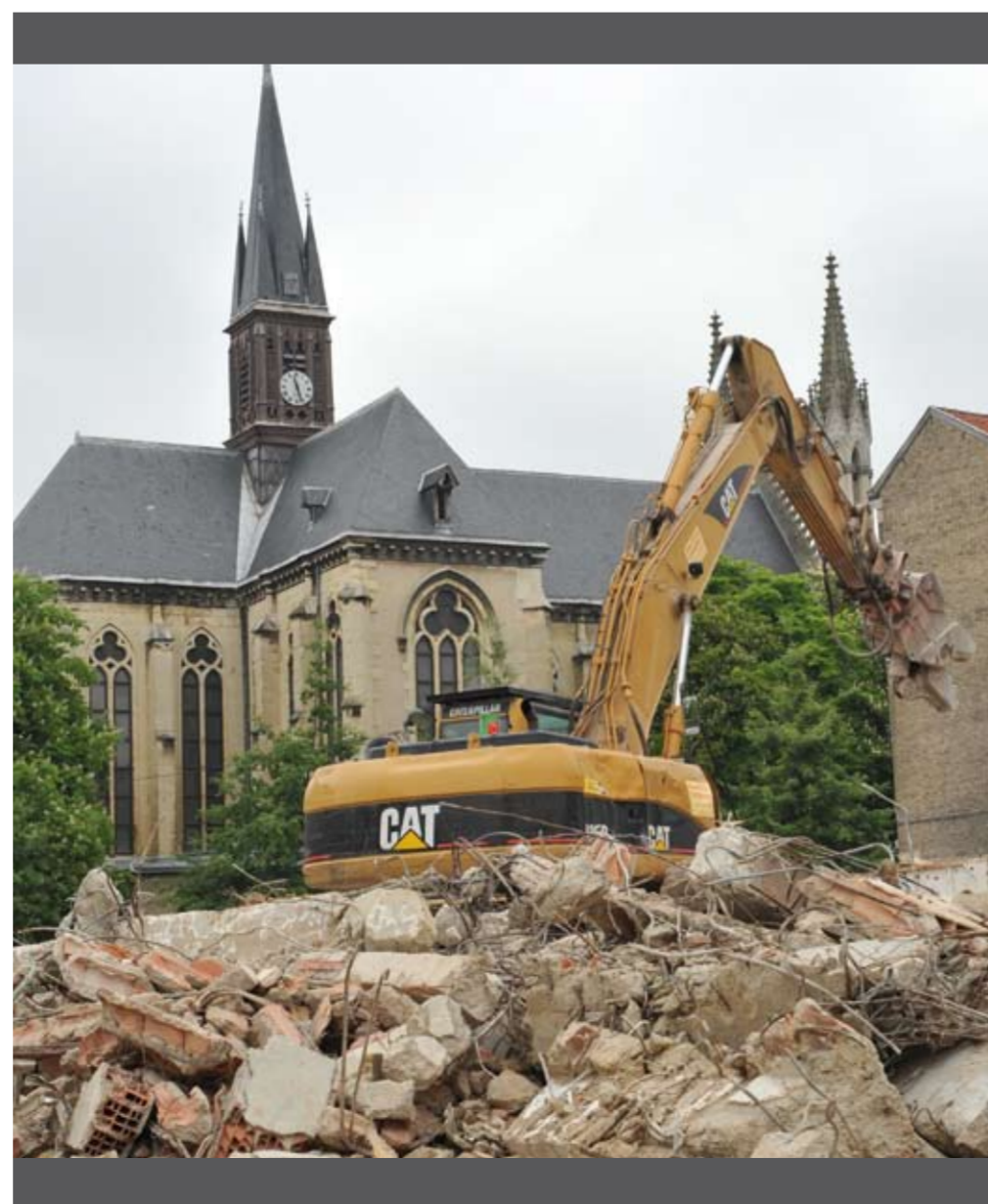
Les derniers vestiges de l'usine Fossier avant la création du parking provisoire ouvert en juin dernier.
